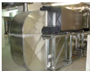
Fabrication de gaines Raccordement de CTA
