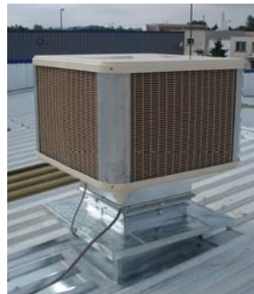
Pose de groupes de refroidissement
